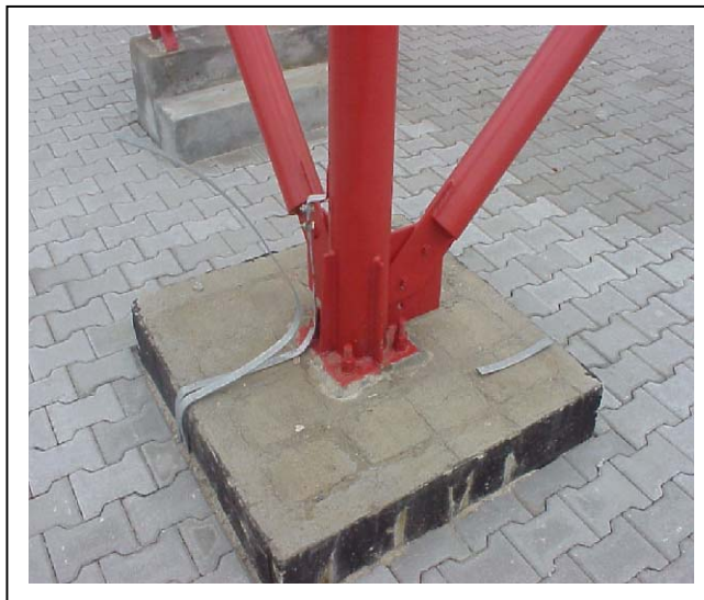
Figura 38. Detalles de las bases de la torre.
