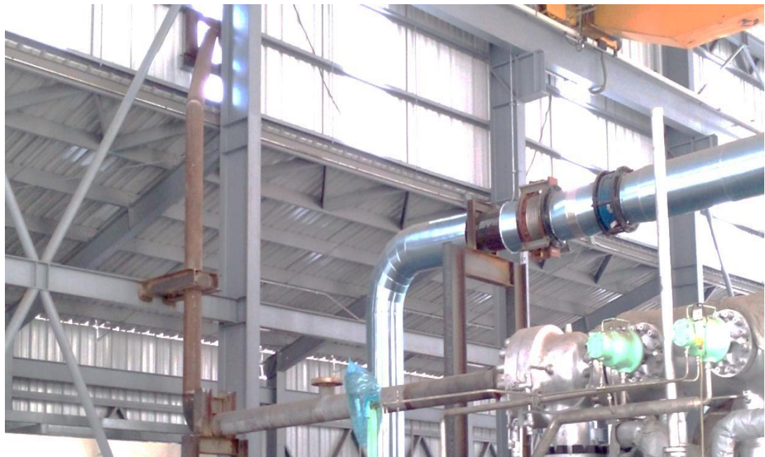
Figura 39. Tubería provisional para soplado
