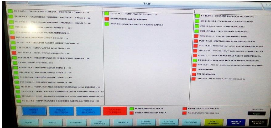
Figura 30. Pantalla de inicio de arranque de turbina
