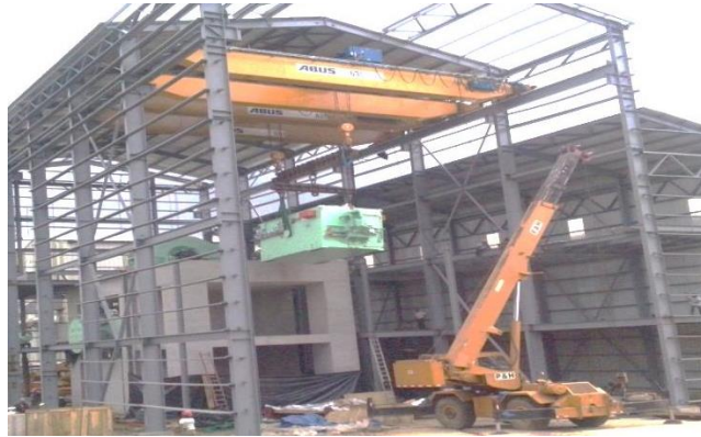
Figura 24. Montaje del generador
