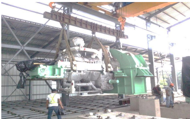
Figura 23. Montaje de turbina
