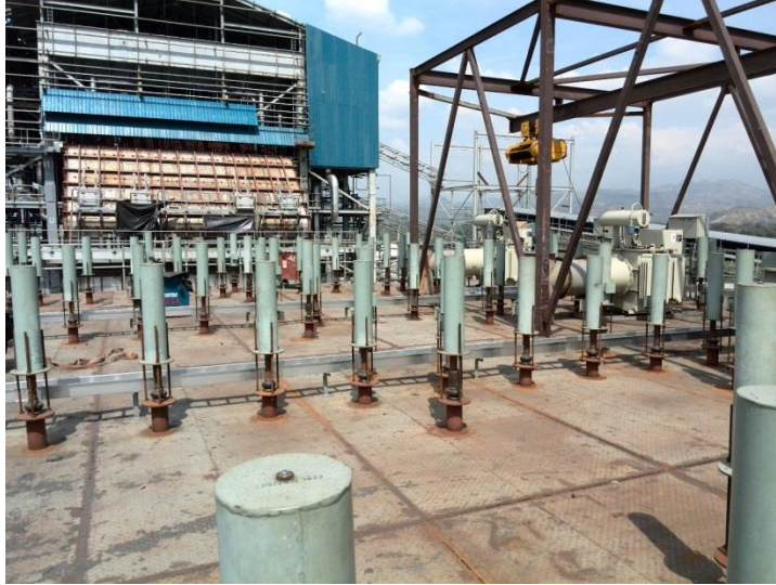
Figura 18. Martillos del precipitador electrostático
