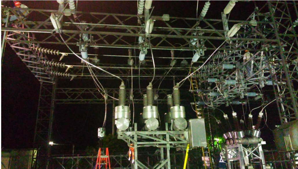
Figura 12. Trabajos para la modificación de la subestación 69 kV
