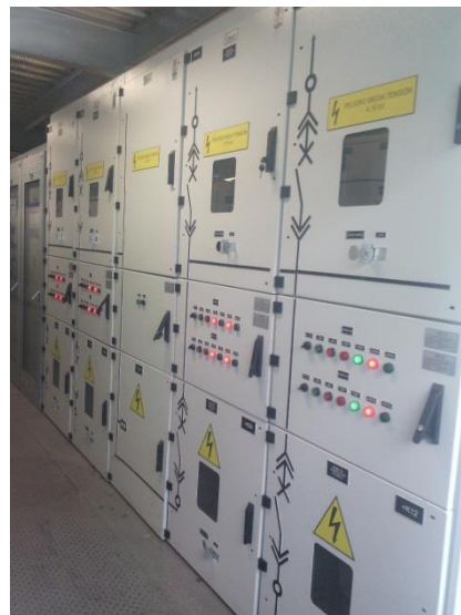
Figura 4. Celdas 4,16 kV
