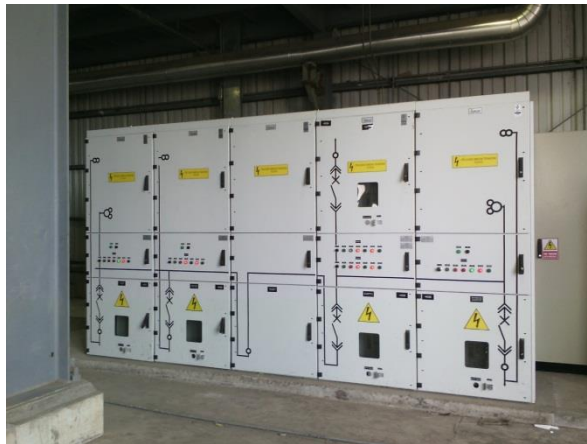
Figura 3. Celdas 13,8 kV
