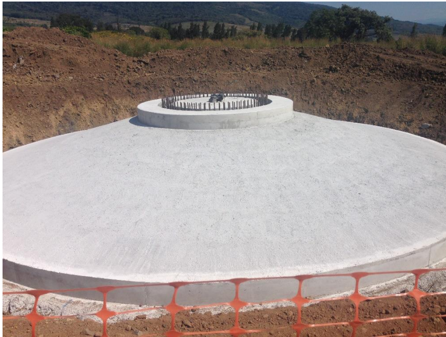
Figura 20. Cimentación de aerogeneradores
