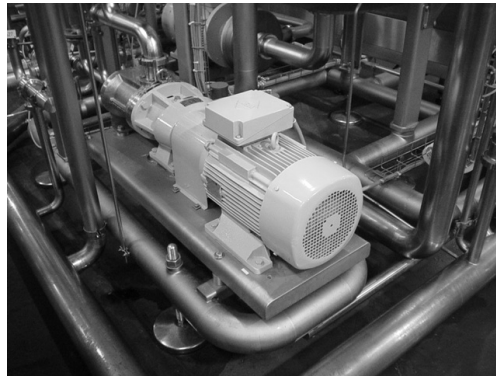
Figura 32. Foto de motobomba de jarabe
