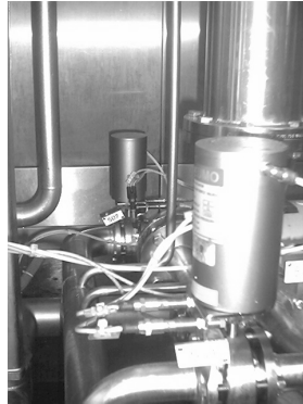
Figura 34. Foto de válvula de mariposa
