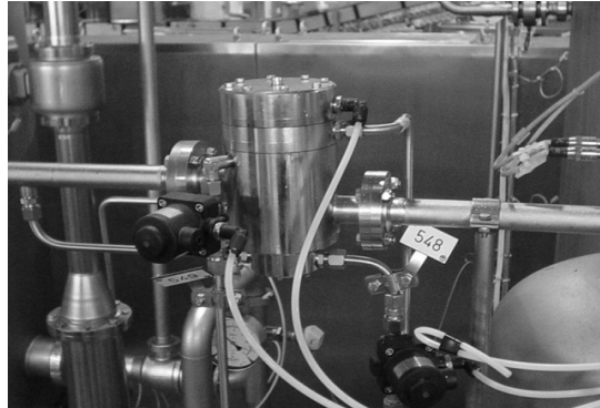
Figura 37. Foto de reguladora de presión
