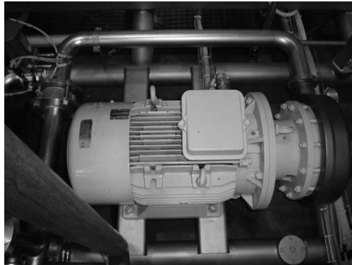
Figura 31. Foto de motobomba de carbonatación
