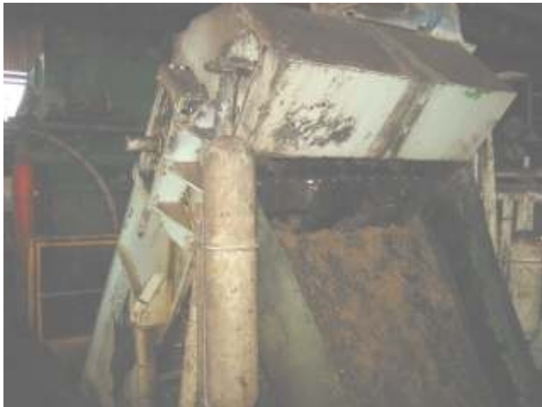
Figura 14. Vista lateral molino
