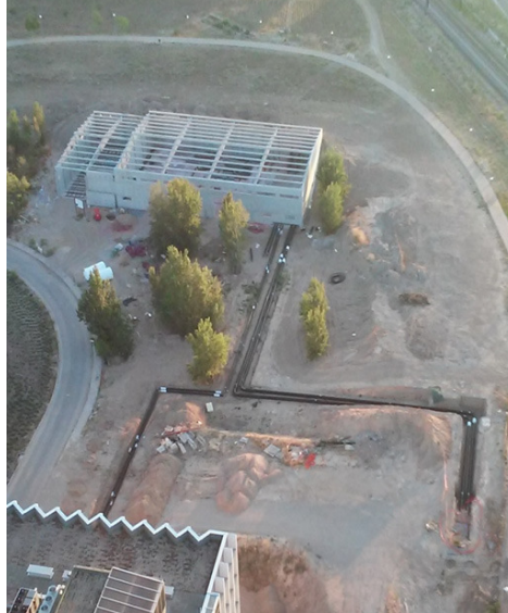
Figura 3. Vista aérea de central térmica
