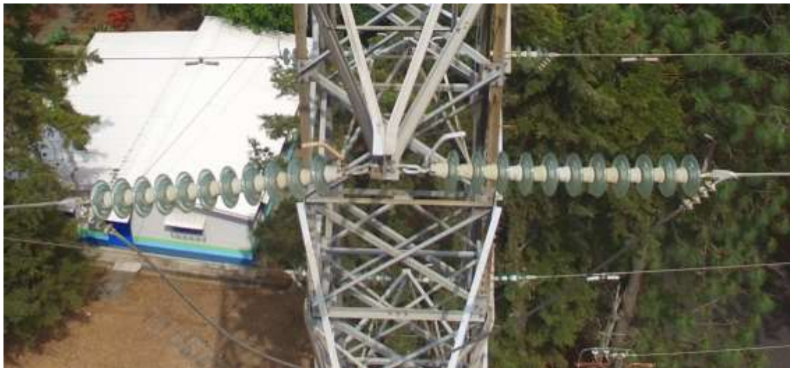
Figura 68. Vista local de aislamiento
