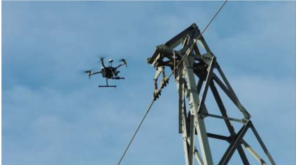
Figura 55. Dron Matrice 210 RTK inspeccionando aislamiento
