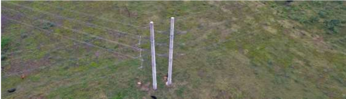
Figura 62. Vista de estructura de poste
