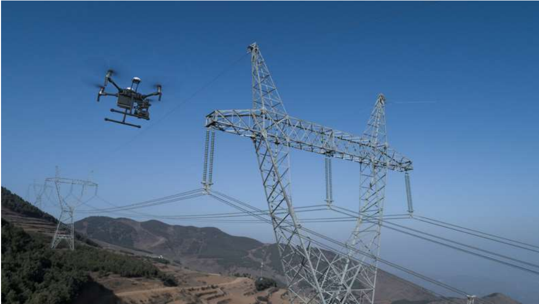
Figura 53. Dron Matrice 210 RTK inspeccionando estructura
