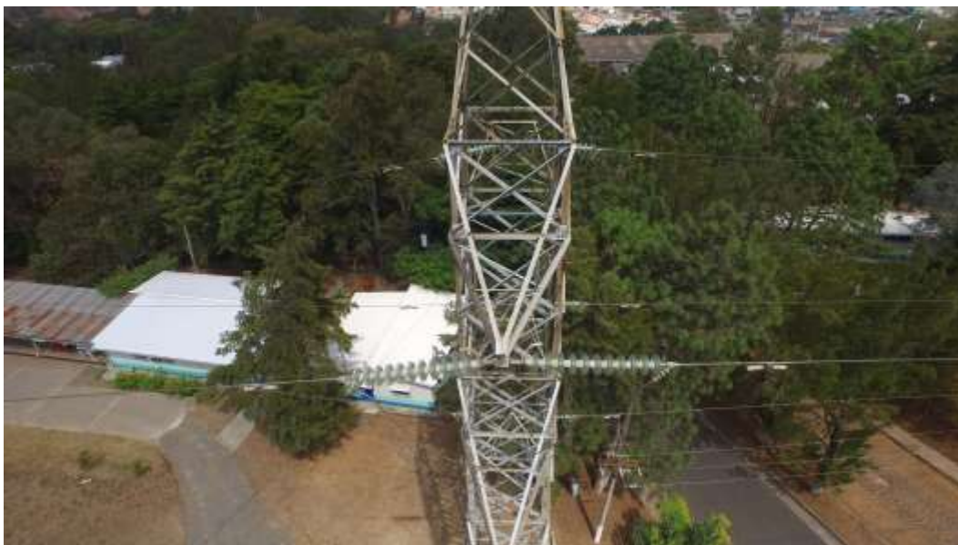
Figura 67. Vista de aislamiento en estructura
