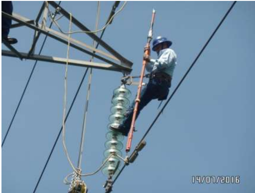
Figura 44. Liniero efectuando cambio de aislamiento
