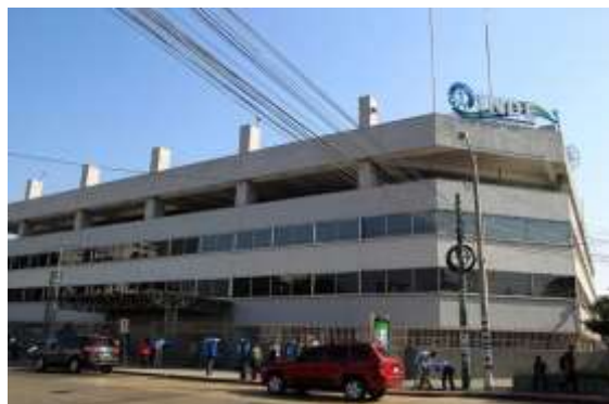
Figura 26. Vista local de sede de ETCEE – INDE
