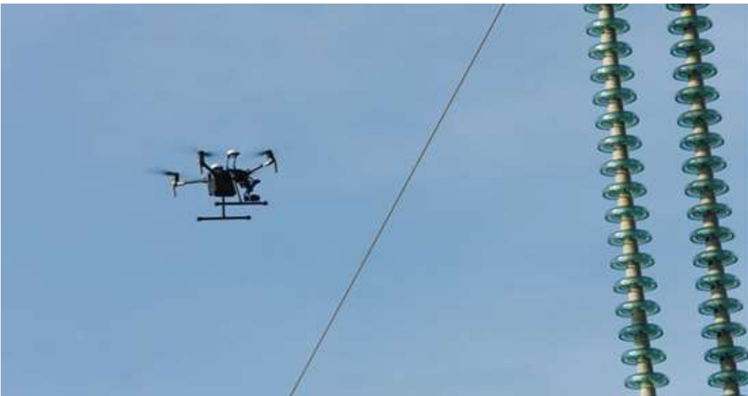
Figura 54. Dron Matrice 210 RTK inspeccionando aislamiento
