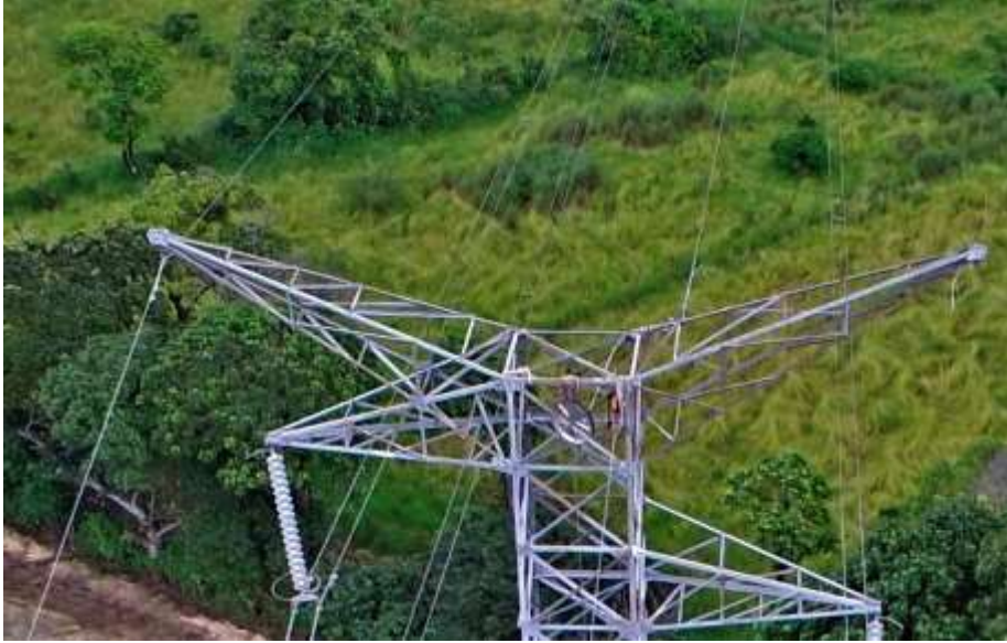
Figura 69. Vista local de capitel
