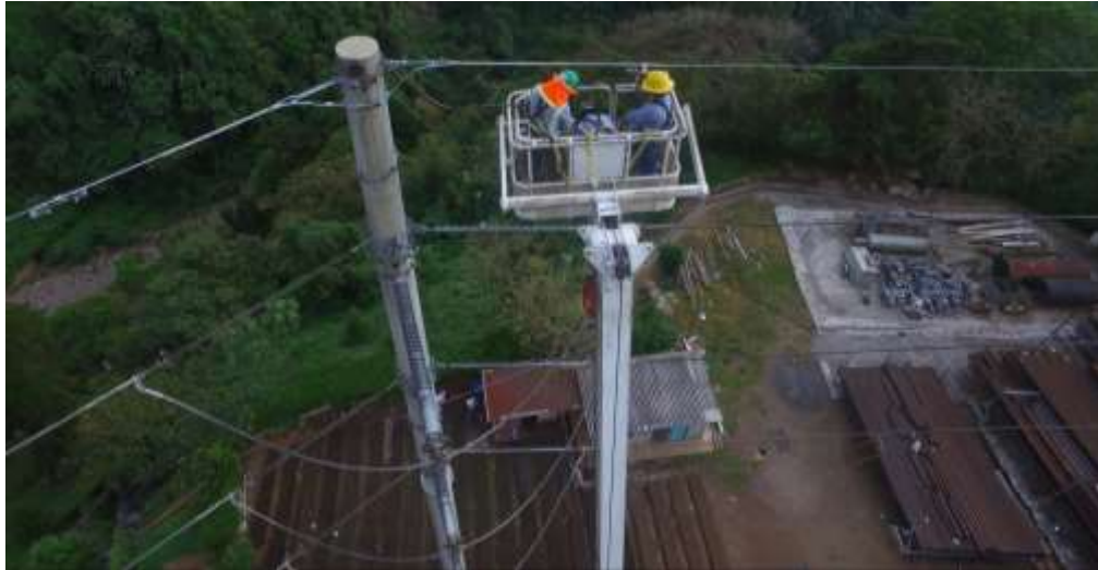
Figura 66. Vista de reparación efectuada a poste
