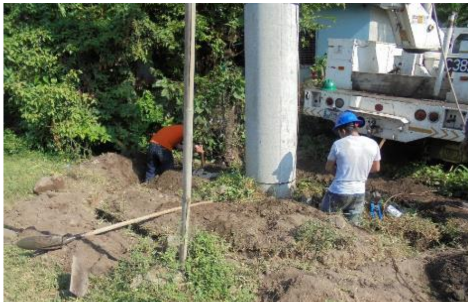
Figura 156. Instalación de sistema de puesta a tierra en configuración anillo con dos varillas
