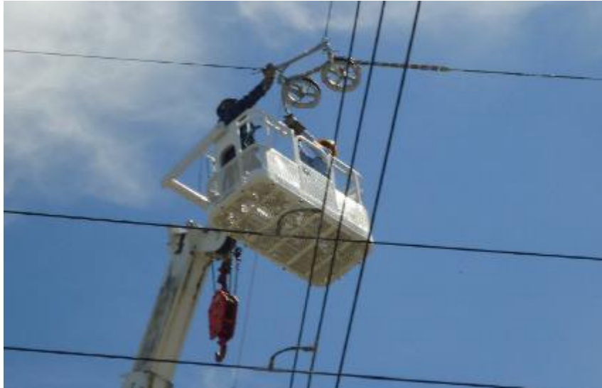
Figura 144. Juego de poleas para cruces para ángulos mayores de 25 °
