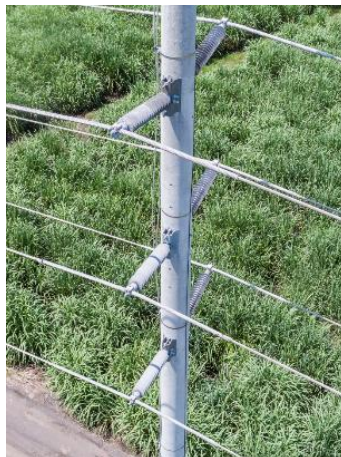
Figura 151. Engrapado en aisladores tipo poste
