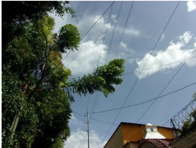
Figura 183. Árbol sobre línea de transmisión
