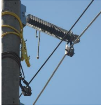
Figura 135. Polea instalada para tendido de conductores
