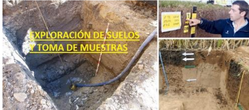
Figura 14. Estudio de suelo por excavación de cielo abierto
