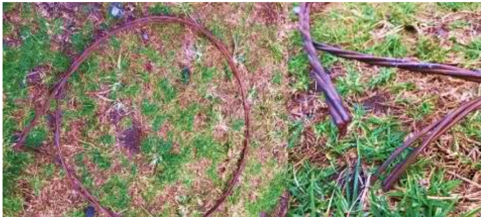
Figura 89. Cable copperweld núm. 2
