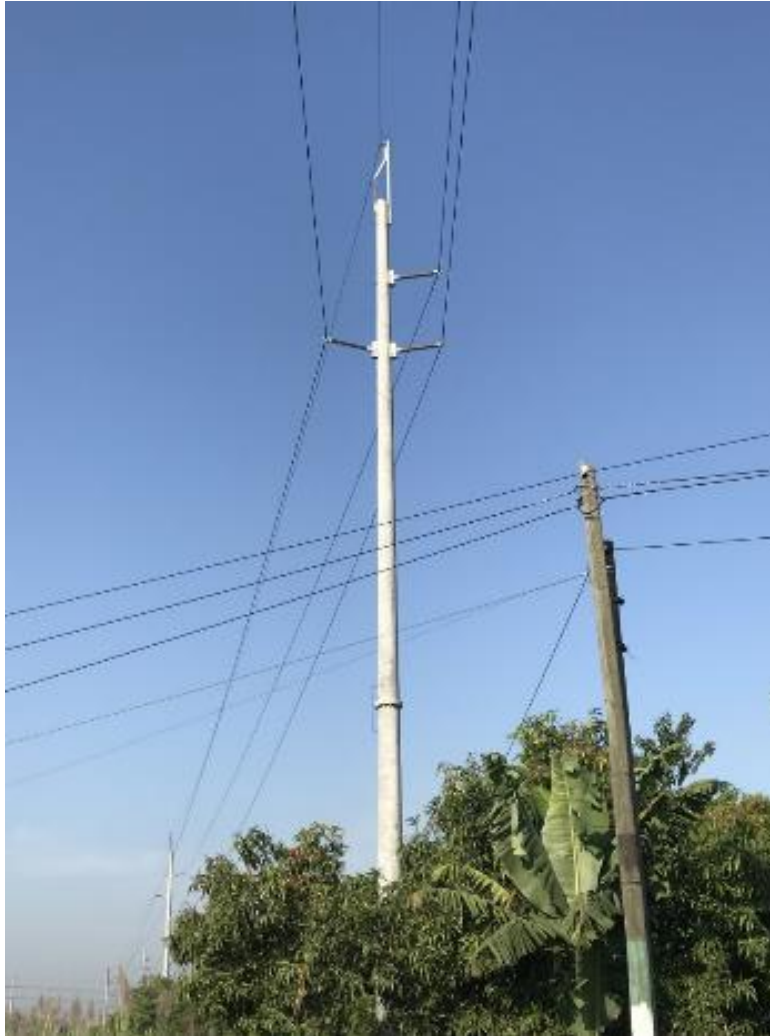
Figura 110. Monopolo de concreto de 24 metros clase 2000 en configuración IIA
