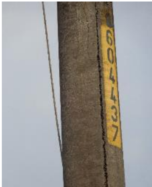
Figura 175. Poste dañado
