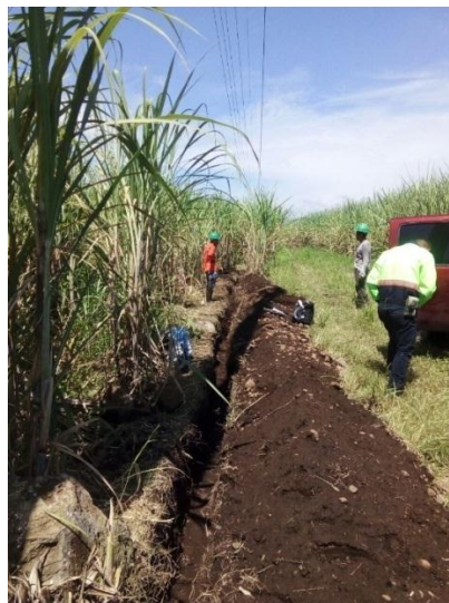
Figura 160. Excavación de zanja para un sistema de puesta a tierra
