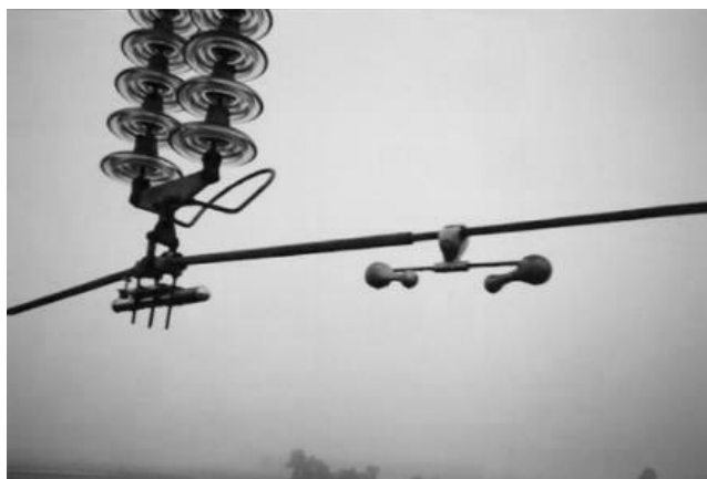
Figura 155. Amortiguadores de líneas de transmisión
