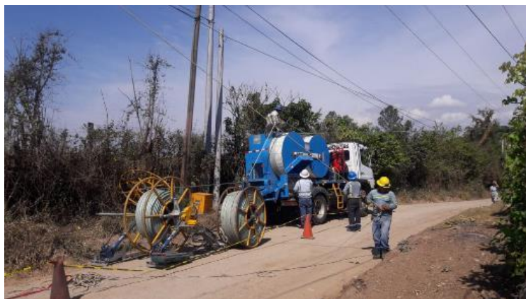
Figura 142. M3quina de tendido con gu3a
