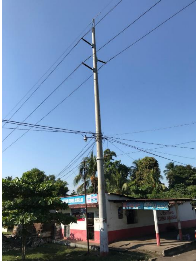
Figura 107. Monopolo de hormigón de 21 metros clase 2000 con bayoneta en configuración II
