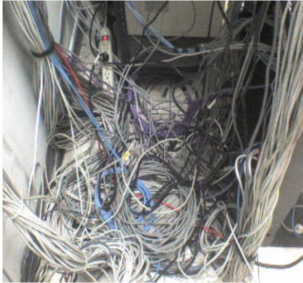
Figura 38 Cableado expuesto
