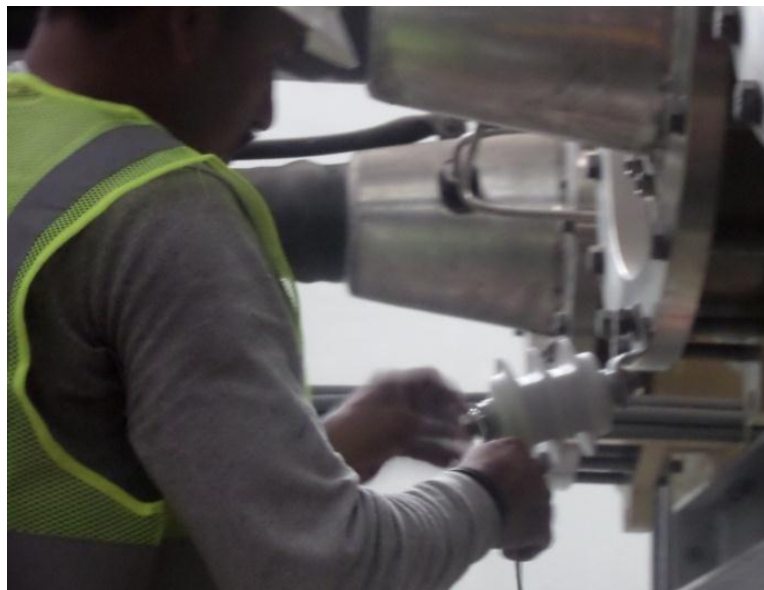
Figura 63. Instalación de resistencias no lineales
