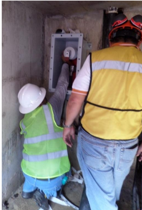
Figura 65. Instalación de sistema puesta a tierra
