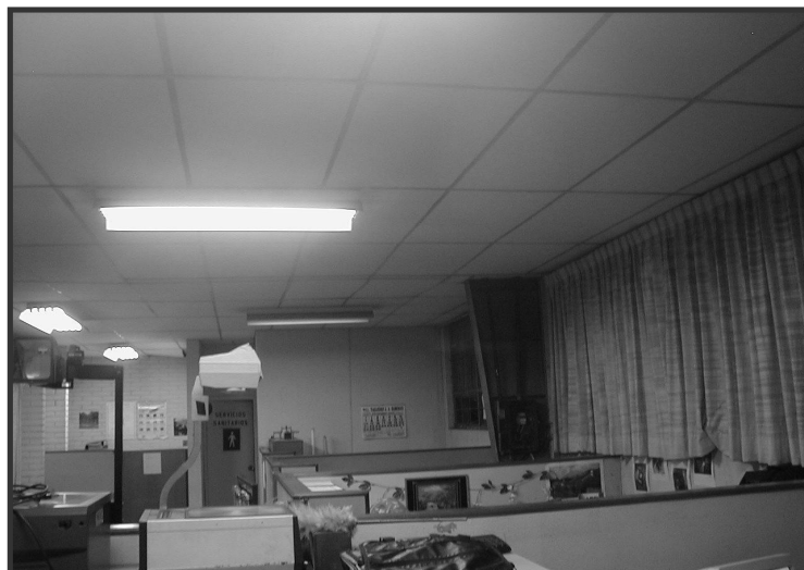
Figura 4. Techo de oficinas
