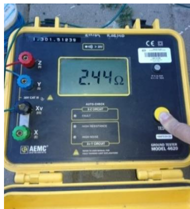
Figura 49. Medición de resistencia del polo de tierra de aterrizado de equipos
