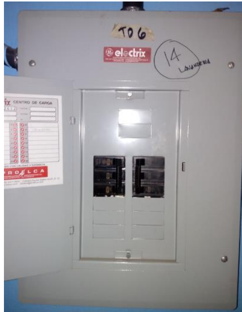
Figura 36. Interruptor en derivación
