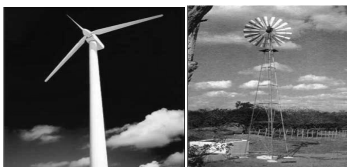
Figura 5. Aerogeneradores horizontales, tripala (izquierda), multipala para bombeo (derecha)
