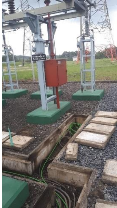
Figura 102. Tendido de cables hacia tableros de PCYM
