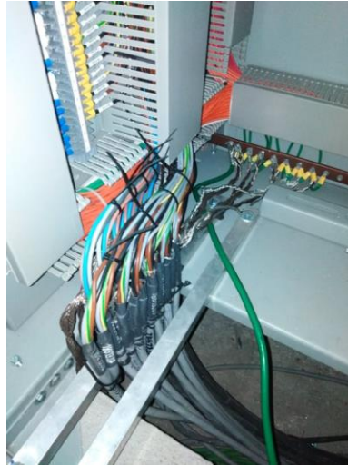
Figura 103. Integración de cableado a tableros de PCYM
