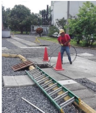
Figura 122. Tendido de cableado de fibra óptica
