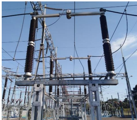
Figura 5. Seccionadores
