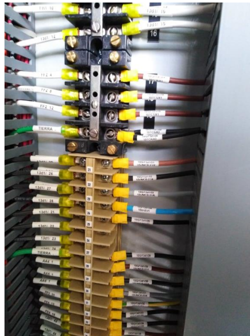
Figura 104. Embornado y etiquetado de tableros de PCYM
