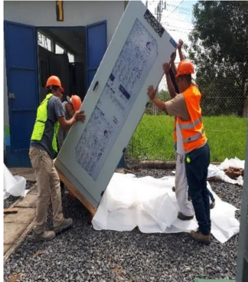
Figura 101. Montaje de tableros de PCYM
