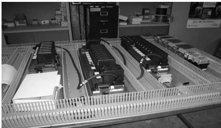
Figura 57. Instalación de tarjetas, fuentes, etcétera
