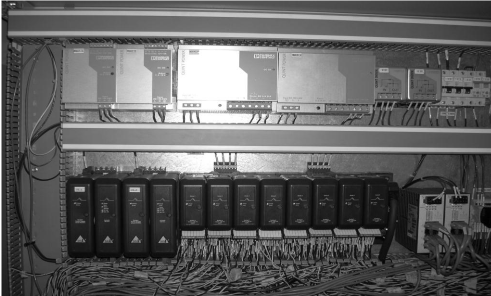
Figura 60. Cableado de señales analógicas
