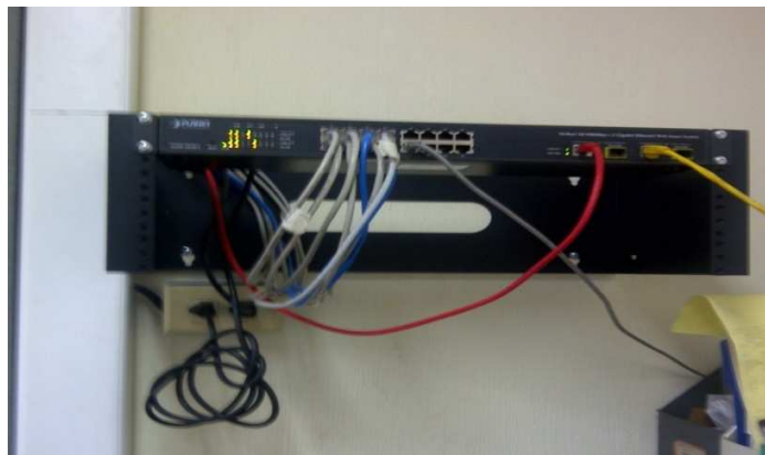
Figura 18. Instalación de switch y cables en edificio ERIS
