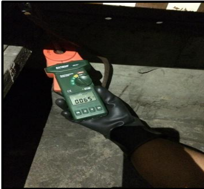
Figura 29. Medición de tierra en subestación
