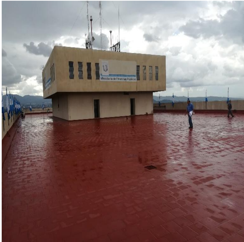
Figura 65. Azotea del edificio torre
