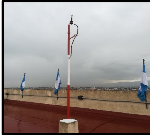
Figura 31. Pararrayos punta simple Franklin (PSF)
