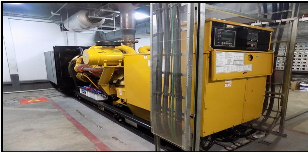
Figura 19. Planta de Emergencia 725 kW (Equipo Electrónico) (15)
