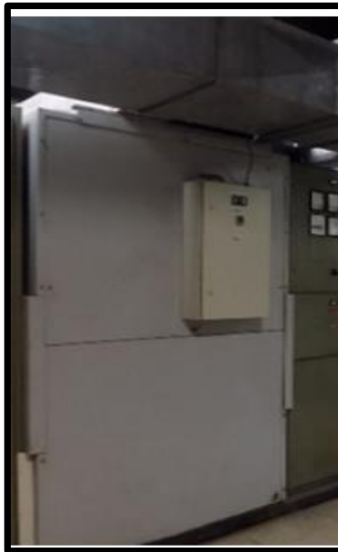
Figura 14. Transformador seco (4-10)
