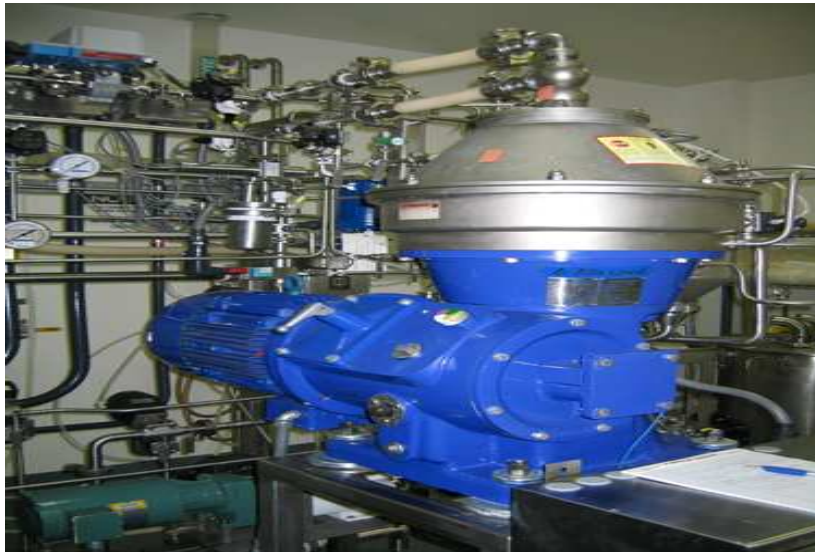
Figura 3. Casa de tratamiento de combustible
