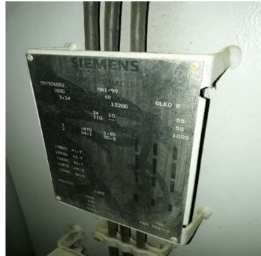
Figura 45. Placa de transformador tipo subestación marca SIEMENS
