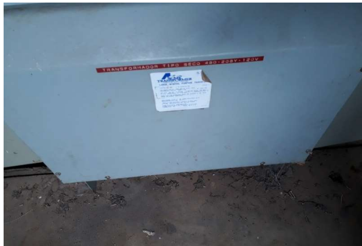
Figura 100. Transformador seco ACME Electric
