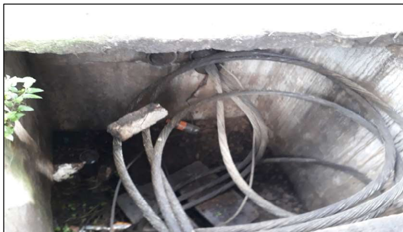
Figura 107. Estado interno caja de registro acometida principal
