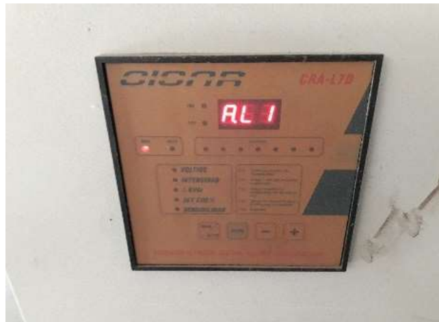
Figura 86. Regulador de energía reactiva CRA-L7D
