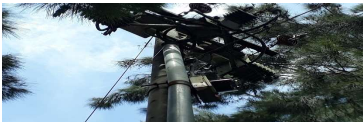
Figura 32. Medición primaria acometida Campo Marte
