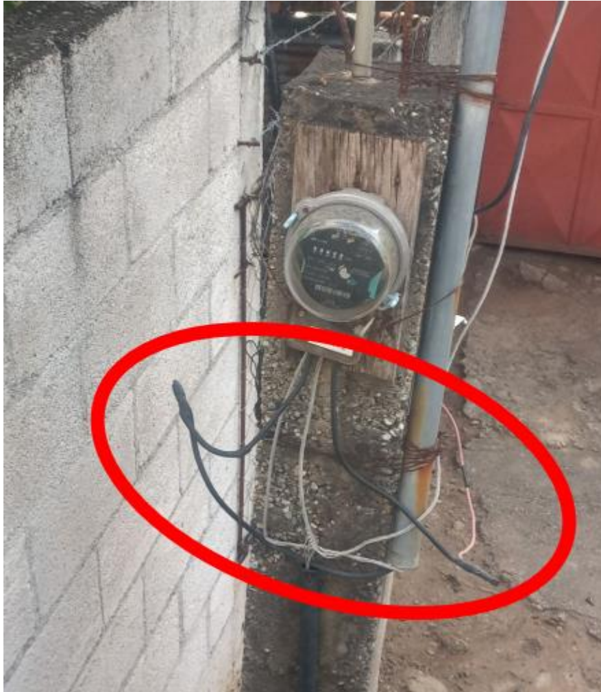
Figura 10. Acometida manipulada para fraude de energía
