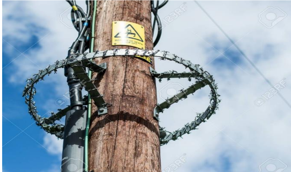
Figura 26. Estructuras con alambres de púas en postes de distribución
