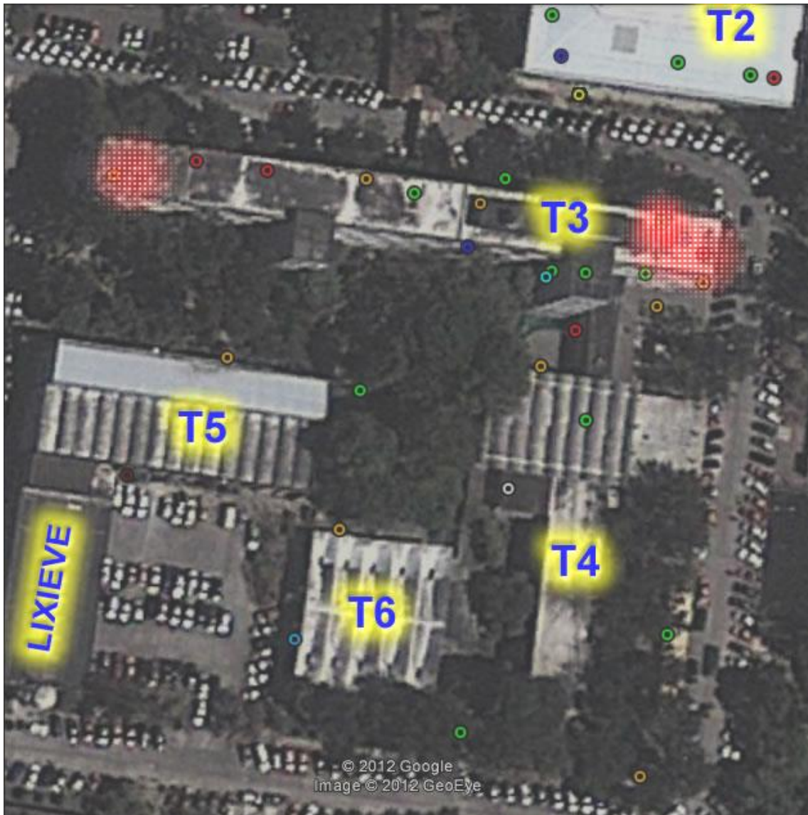
Figura 14. Cobertura. Edificio T3, 2 do nivel
