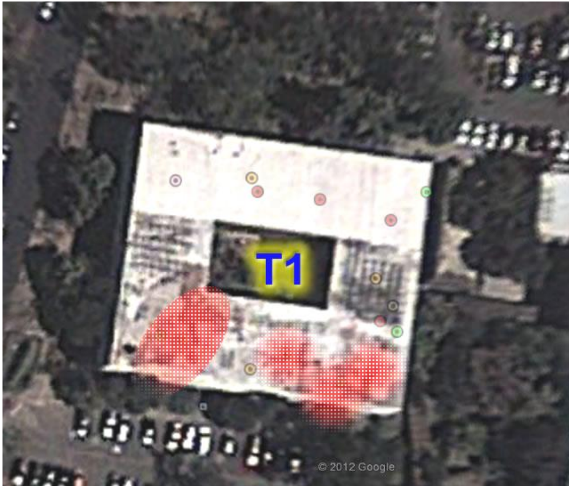
Figura 82. Cobertura actual. Edificio T1, 1 er nivel
