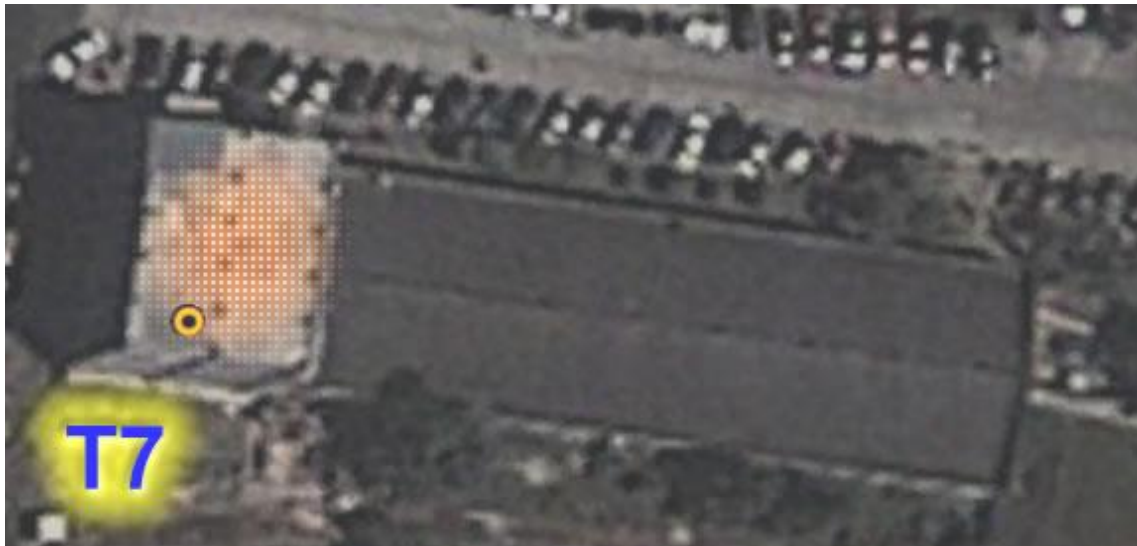
Figura 58. Nuevos APs. Edificio T7, 2 do nivel
