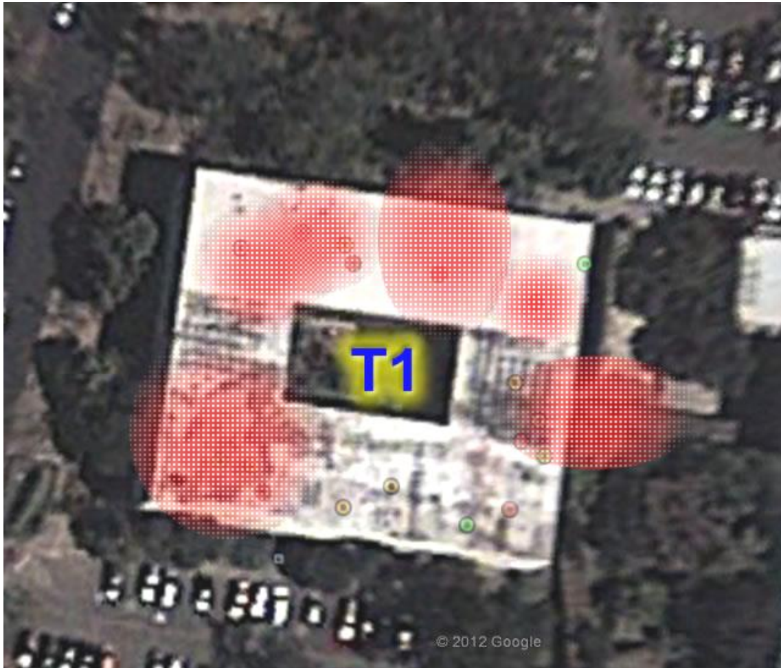
Figura 10. Cobertura. Edificio T1, 2 do nivel
