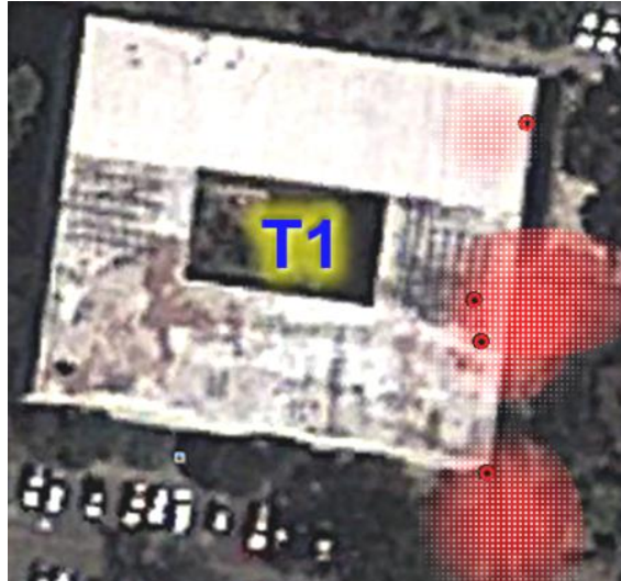
Figura 87. Cobertura completa con nuevas redes. Edificio T1, exteriores
