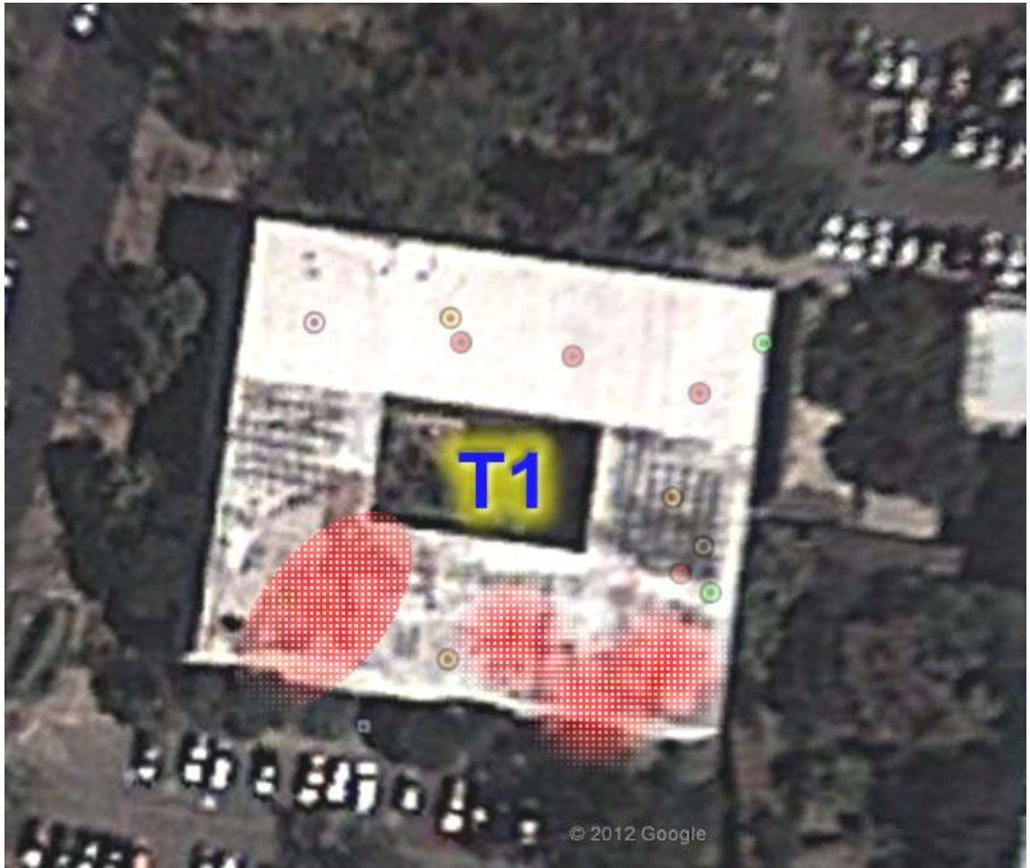
Figura 9. Cobertura. Edificio T1, 1 er nivel
