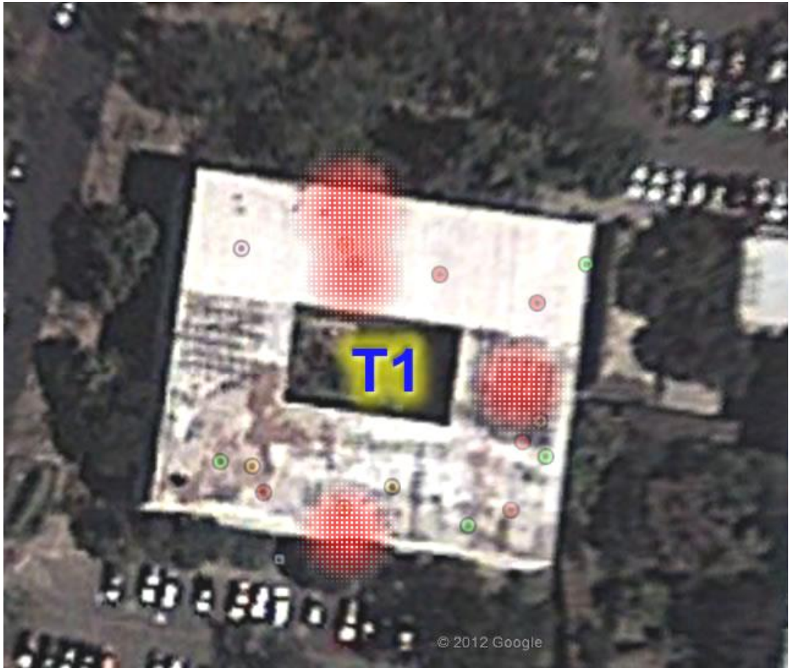
Figura 11. Cobertura. Edificio T1, 3 er nivel
