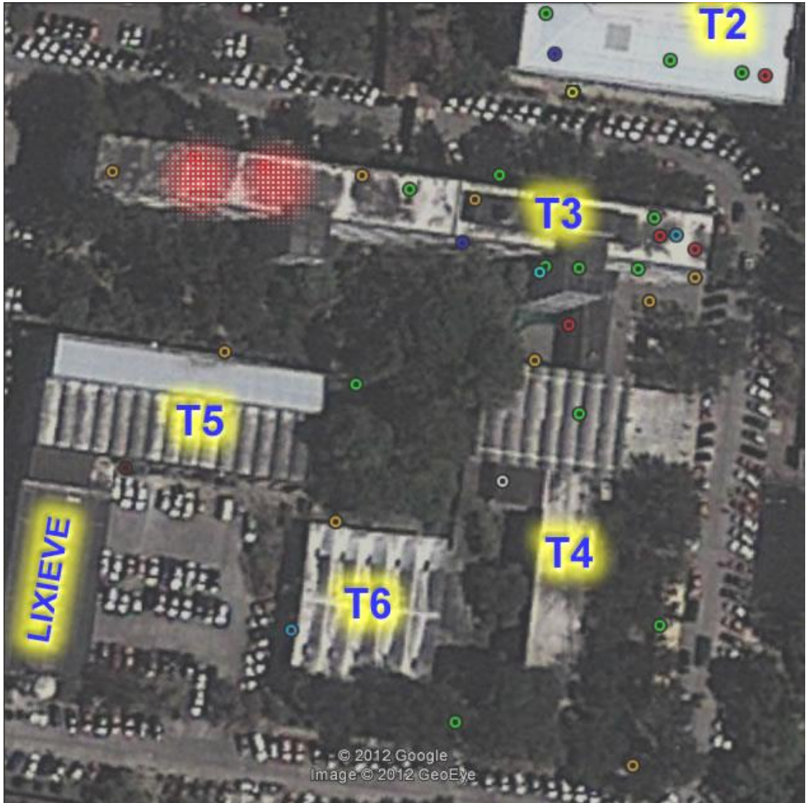
Figura 13. Cobertura. Edificio T3, 1 er nivel
