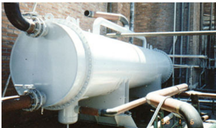
Figura 6. Condensador enfriado por agua
