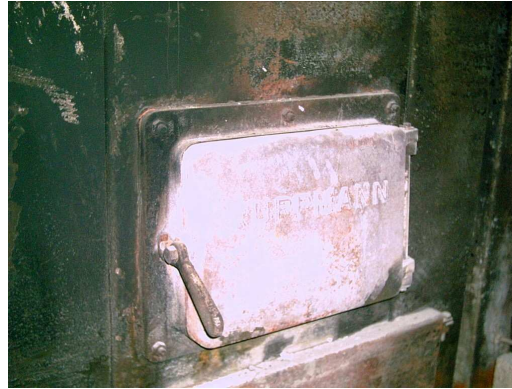
Figura 21. Limpieza de los hornos
