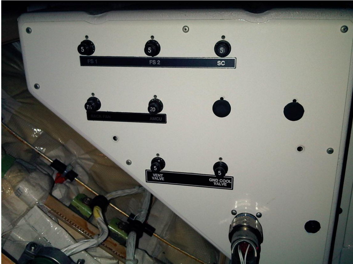
Figura 8. Panel de fusibles Sistema de Entretenimiento IFE
