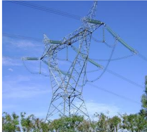
Figura 4. Torre de transposición
