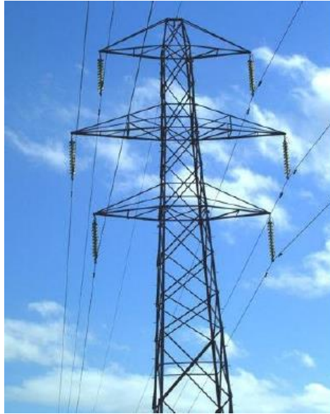
Figura 2. Torre de suspensión tangente
