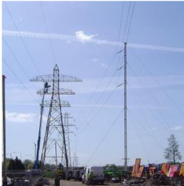
Figura 23. Torre de transmisión de emergencia
