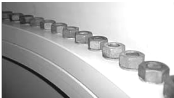
Figura 9. Unión por pernos
