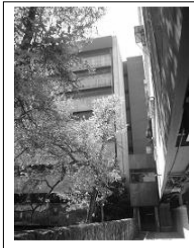
Figura 1. Torre de encamamiento HGSJD
