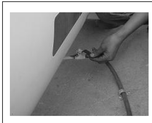
Figura 21. Abertura de la válvula de purga
