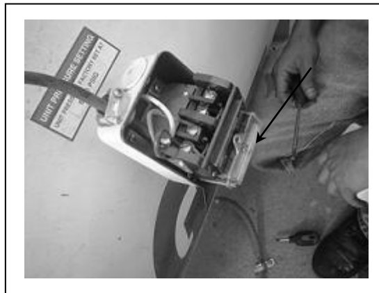
Figura 28. Calibración de la presión
