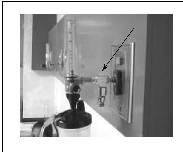
Figura 13. Instalación de accesorios en la toma
