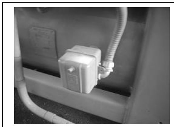
Figura 26. Interruptor (switch) de presión
