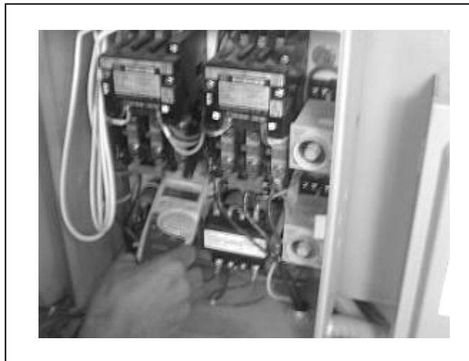
Figura 25. Medición del amperaje
