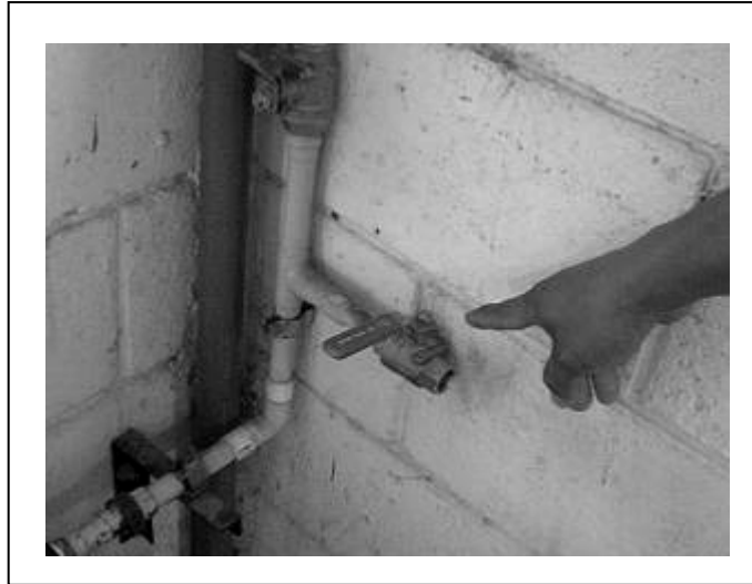
Figura 18. Válvula de purga que se debe abrir
