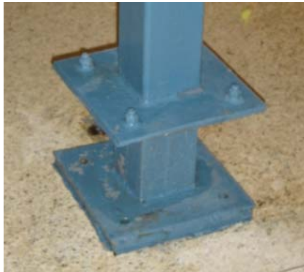
FIGURA 70. Cimiento colocado para clasificador de cortes
