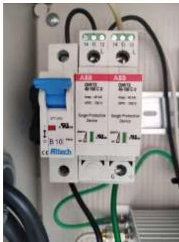
*Nota.* Protección contra sobre tensiones y contra sobre corrientes. Que poseen las estaciones de detección de descargas electroatmosféricas. Elaboración propia.
