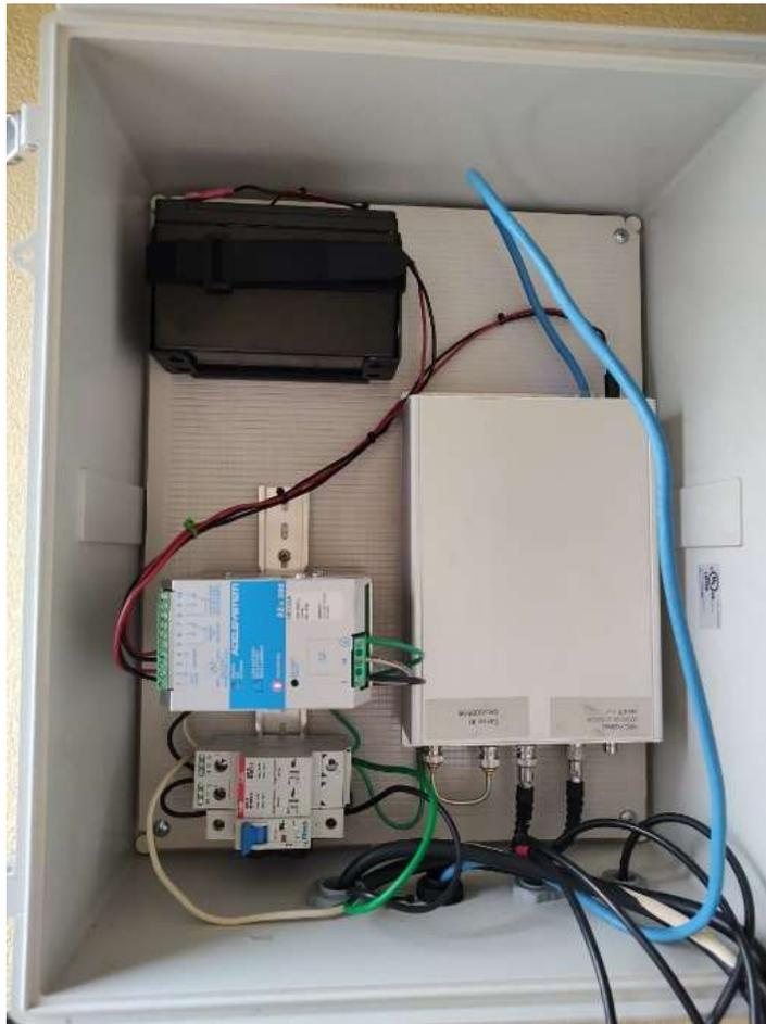
*Nota.* Componentes internos de una estación de detección de descargas electroatmosféricas. Elaboración propia, realizado con Paint.
