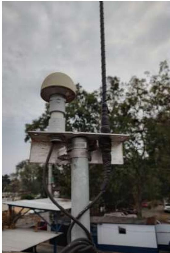
*Nota.* Antena GPS y antena de golpes, suetado al mástil de estación INSIVUMEH GT.
