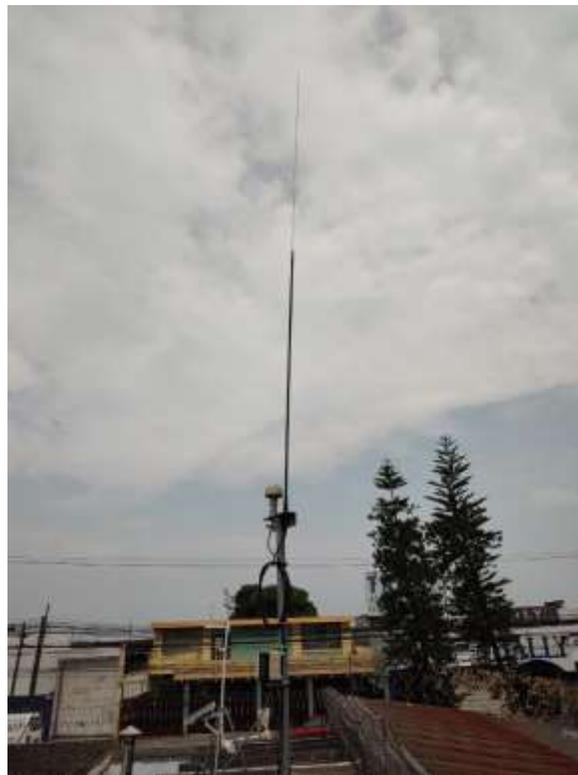
*Nota.* El mástil, la antena GPS y la antena de golpe son componentes fundamentales de una estación de detección de descargas electroatmosféricas. Elaboración propia
