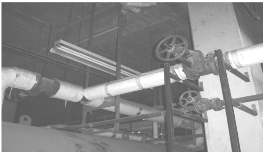
Figura 7. Válvula de compuerta
