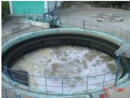
Figura No. 11 Desarenador del tipo "Swirl" o "Grid chamber"
