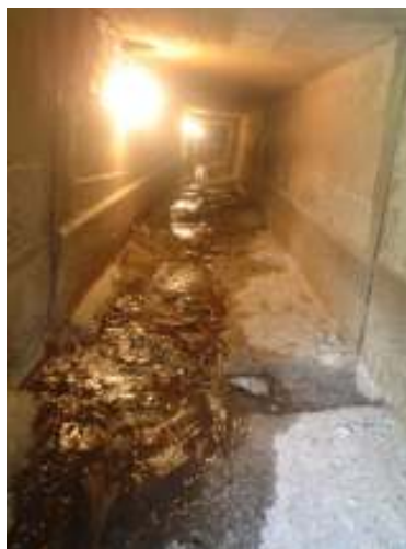
Figura No. 14 Interior del Canal de Demasías
