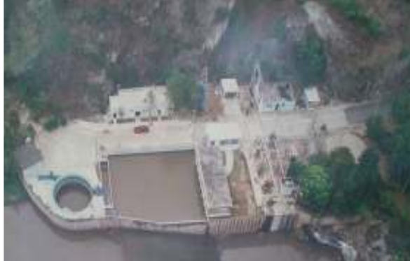
Figura No. 6 Estación de Bombeo dEl Atlántico
