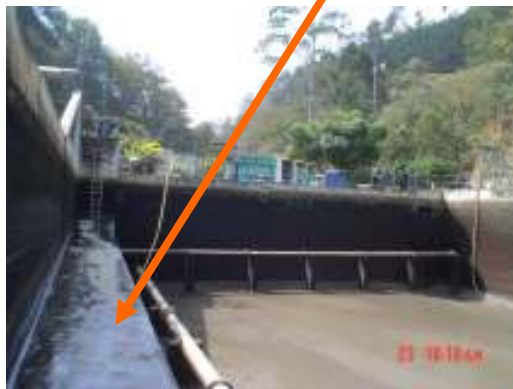
Figura No. 13 Canal de demasías
