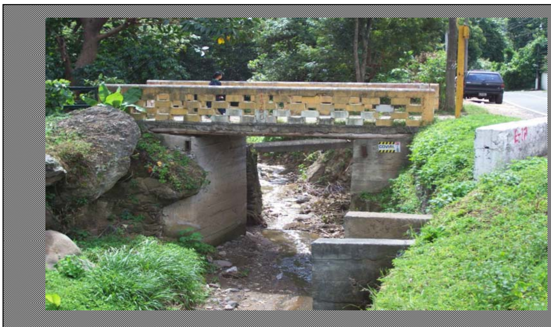
Fotografía 2 Aguas arriba del puente peatonal frente a San Juan Gascón hacia la Antigua Guatemala.
