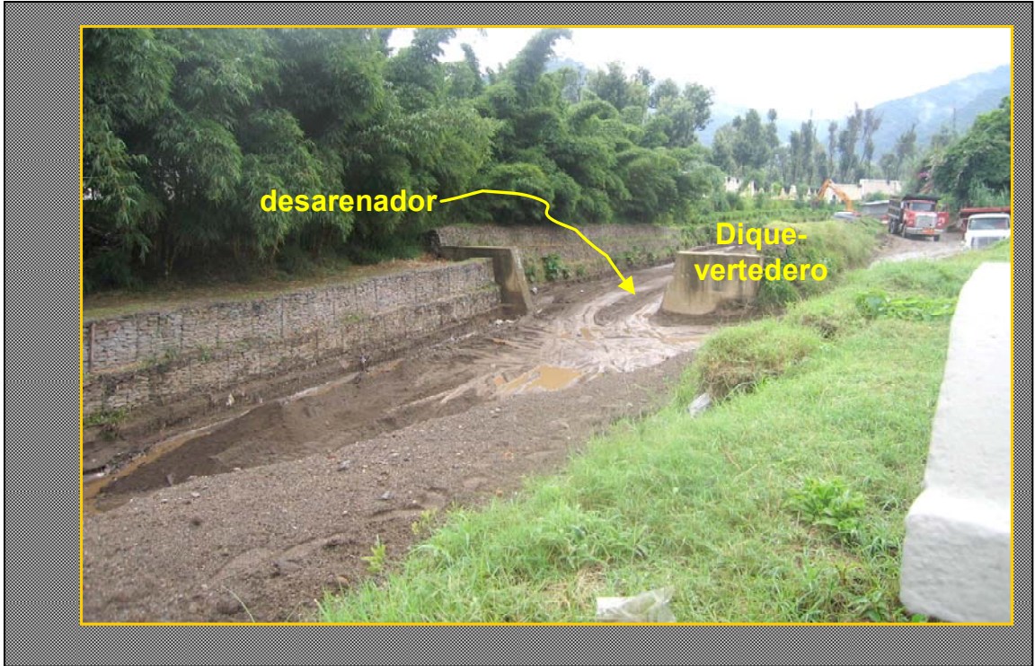
Fotografía 5 80 metros aguas arriba del puente Matazano en la entrada de la Antigua Guatemala.
