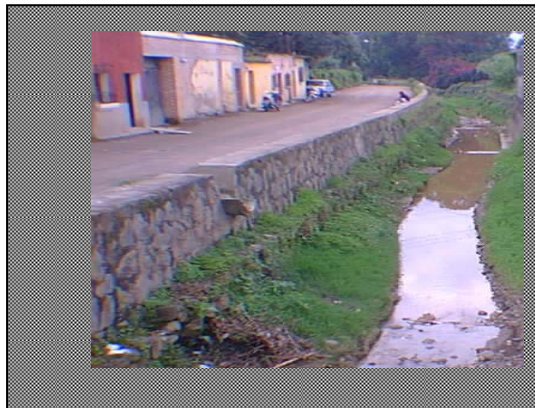
Fotografía 8 Aguas abajo del puente Chipilapa, 500 m después del puente Matazano.
