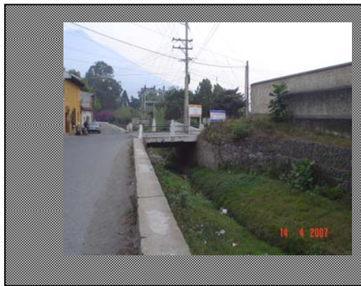
Fotografía 7 Aguas arriba del Puente del puente Chipilapa, aguas abajo del puente Matazano.
