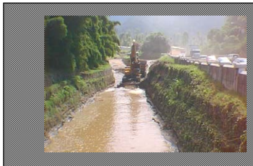
Fotografía 12 Construcción de diques laterales de gavión a la salida de San Juan Gascón, margen derecha.
