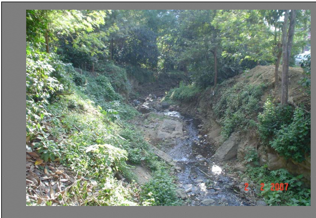
Fotografía 4 Aguas abajo del puente peatonal frente al municipio de San Juan Gascón hacia la Antigua Guatemala.
