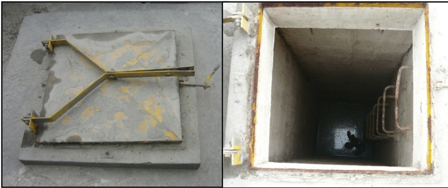
Figura 11: Entrada a fosa séptica
