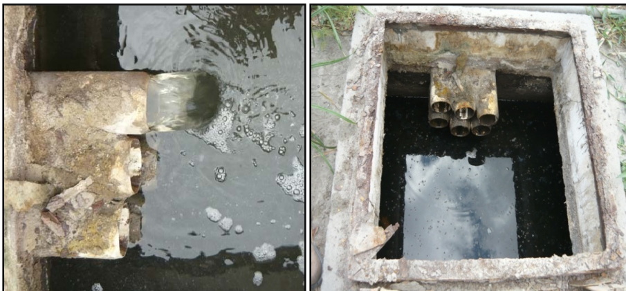
Figura 12: Entrada al humedal
