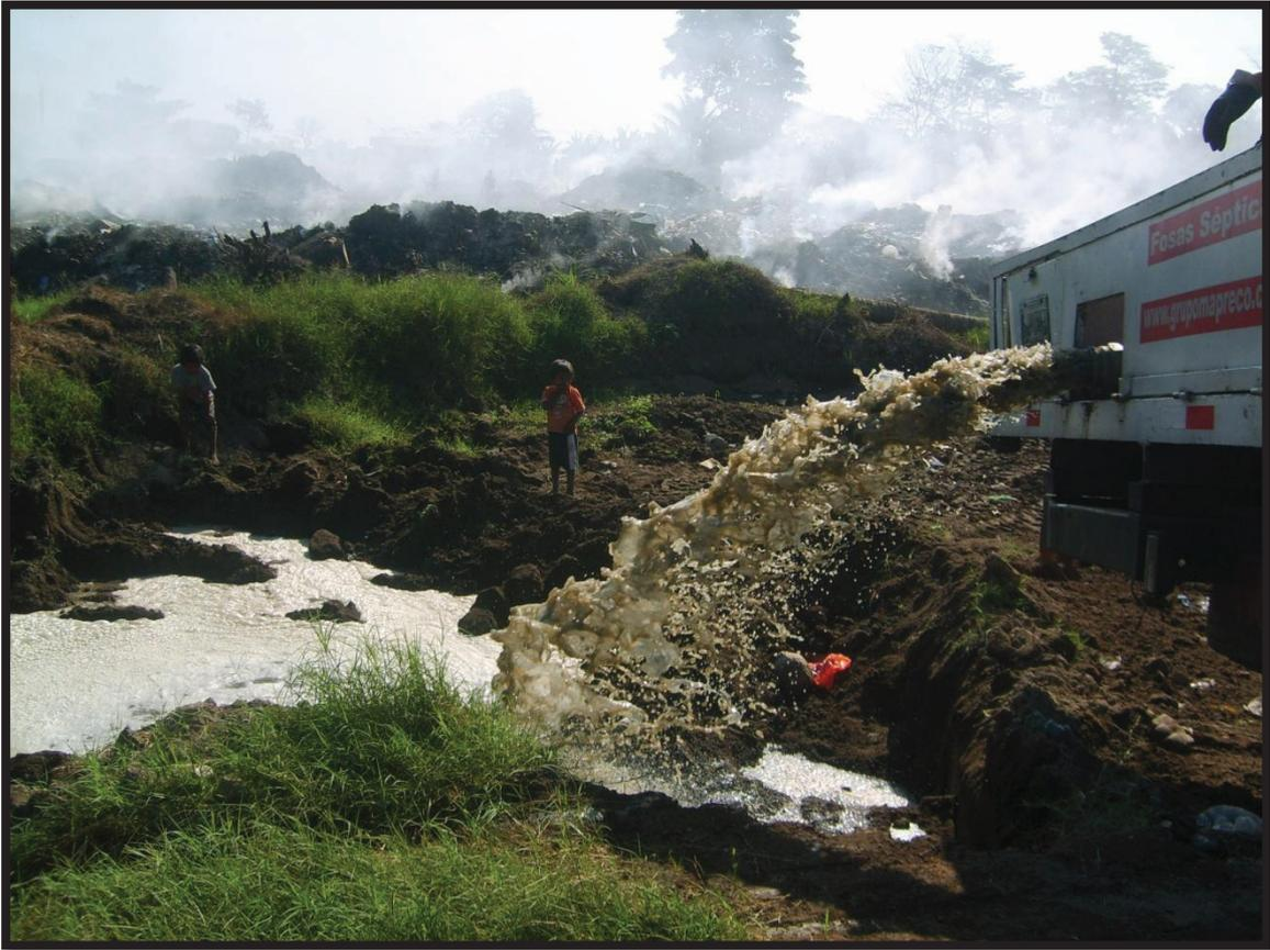
**Figura 16** Descarga del líquido proveniente de fosas sépticas.
