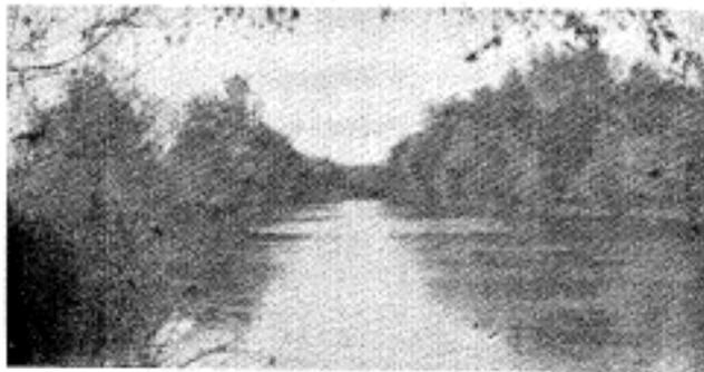
13.  $n = 0.029$ . Canal en tierra excavado en un suelo de limo aluvial, con depósitos de arena en el fondo y crecimiento de pastos.
