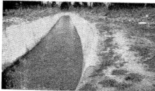
4.  $n = 0.018$ . Revestimiento de concreto lanzado sin tratamiento para alisado. Superficie cubierta por algas finas y fondo con dunas de arena arrastrada.
