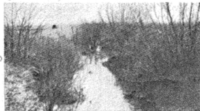
19.  $n = 0.050$ . Canal dragado con pendientes laterales y fondo muy irregulares, en arcilla plástica de color oscuro, con crecimiento de malezas y pastos. Pequeñas variaciones en la sección transversal debidas a variaciones en el tamaño.
