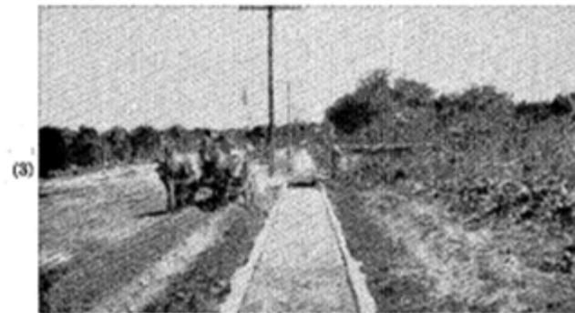
1.  $n = 0.012$ . Canal revestido con placas de concreto con juntas de cemento lisas y una superficie muy lisa, terminada a mano con llana y con lechada de cemento sobre la base de concreto.
