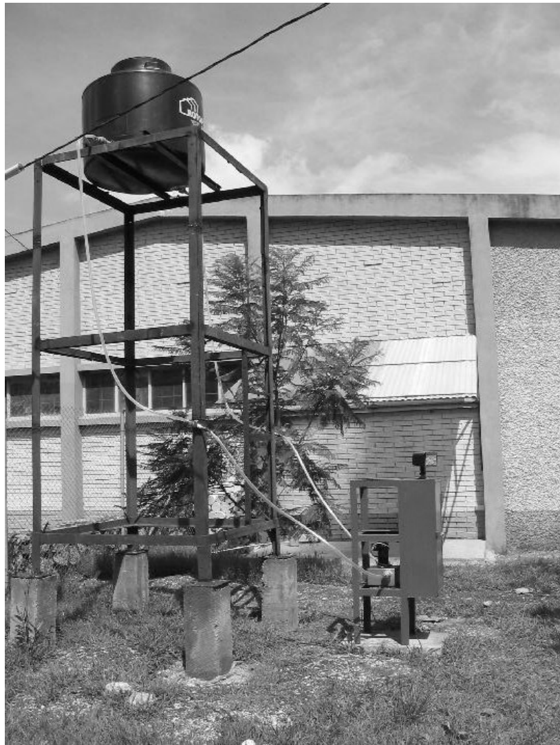
Figura 6. Recorrido de las mangueras desde el depósito de agua hasta la turbina.
