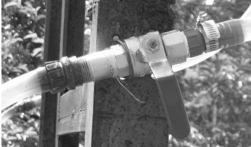
Figura 7. Válvula de bola
