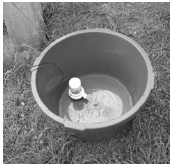
Figura 12. Bomba en el interior del recipiente que se utilizará como tanque de recolección
