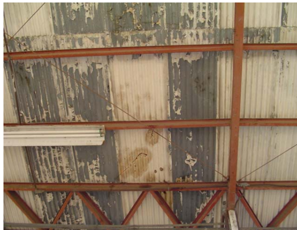
Figura 15. Láminas, costaneras y vigas del departamento de Taller- maquinaria
