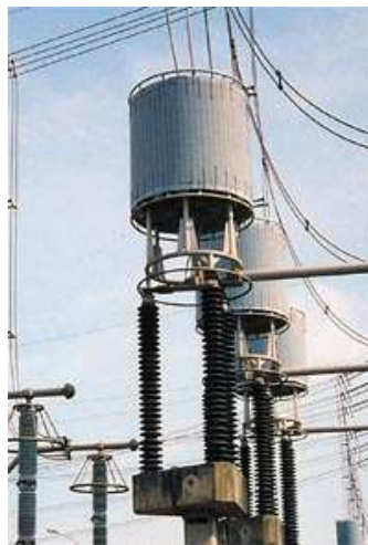
Figura 9. Trampa de onda
