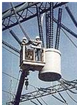
Figura 10. Trampa de onda suspendida por cadenas
