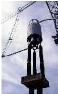
Figura 11. Trampa de onda sobre aisladores
