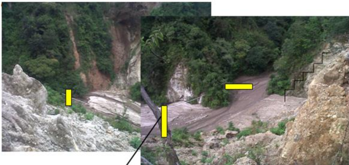
Figura 19. Construcción de muros en el desnivel de la parte superior del cerro
