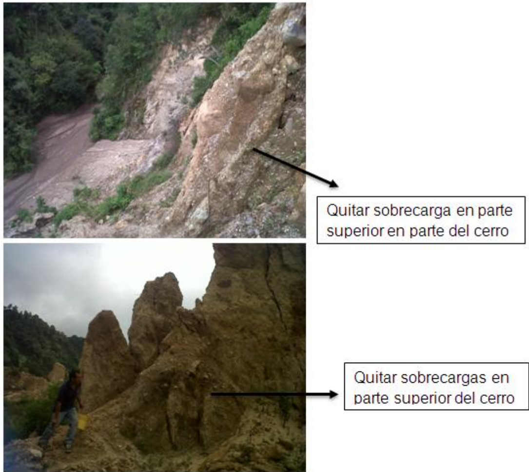
Figura 16. Sobrecargas o material acumulado
