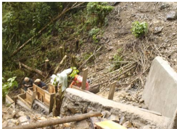
Figura 11. Construcción de lavaderos
