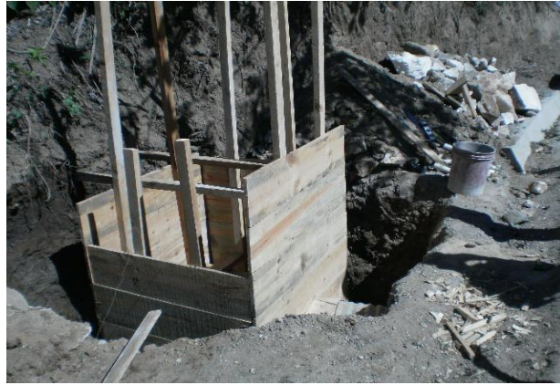
Figura 14. Construcción de caja utilizando concreto ciclópeo
