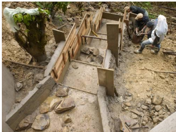
Figura 10. Construcción de lavaderos y disipadores
