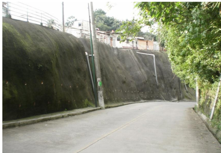
Figura 5. Protección utilizando concreto lanzado y electromalla
