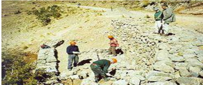
Figura 12. Construcción de muro seco
