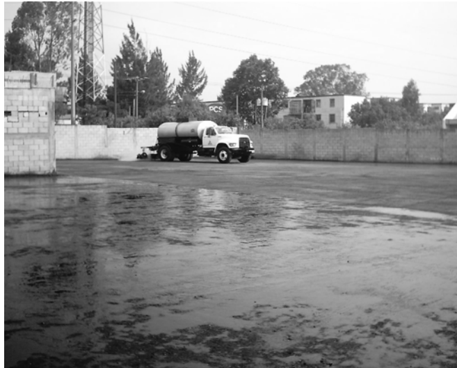
Figura 8. Riego con material bituminoso
