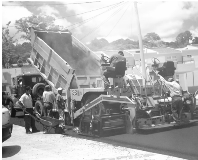
Figura 11. Inicio de pavimentación
