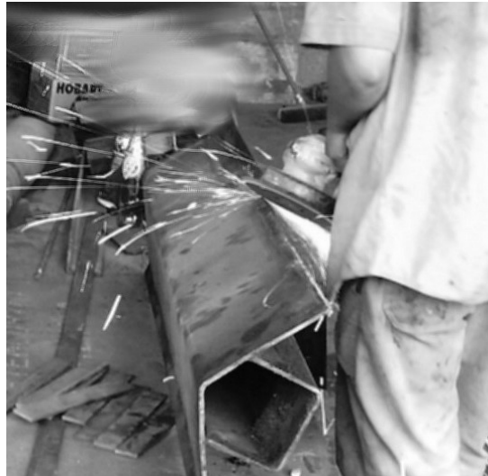
Figura 124. Corte de soldadura con amoladora
