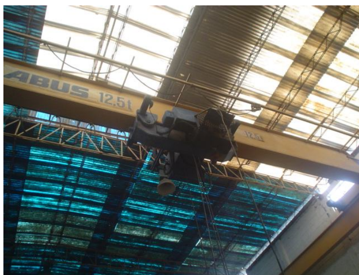
Figura 10. Grúa aérea utilizada para el manejo de materiales
