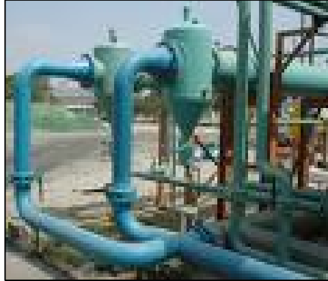
Figura 18. Sistema por orificios de aireación
