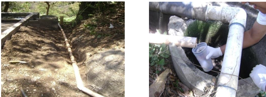
Figura 6. Reparaciones de la tubería y toma de muestra.
