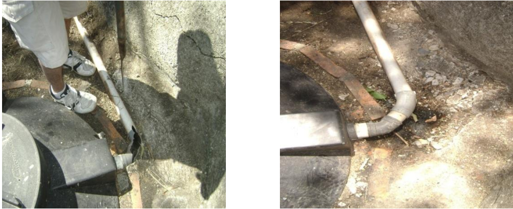
Figura 5. Reparaciones del biodigestor.
