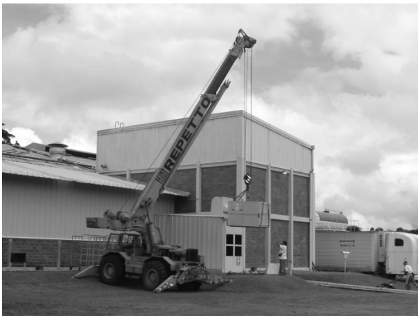
Figura 26. Grúa subiendo un equipo de inyección tipo ABB, modelo RGML 210
