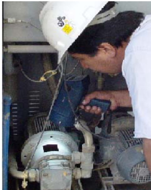
Figura 18 Inspección visual con lámpara estroboscópica
