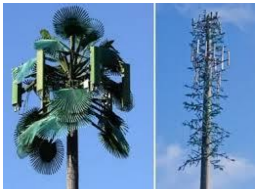
Figura 6. Mimetización de torres de telefonía
