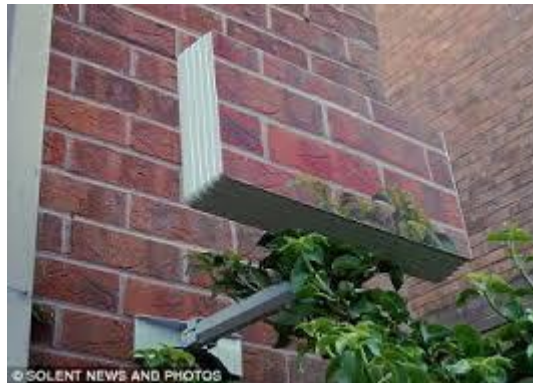
Figura 4. Antena con papel tapiz de ladrillo
