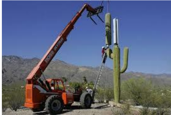
Figura 5. Mimetización de antena omnidireccional
