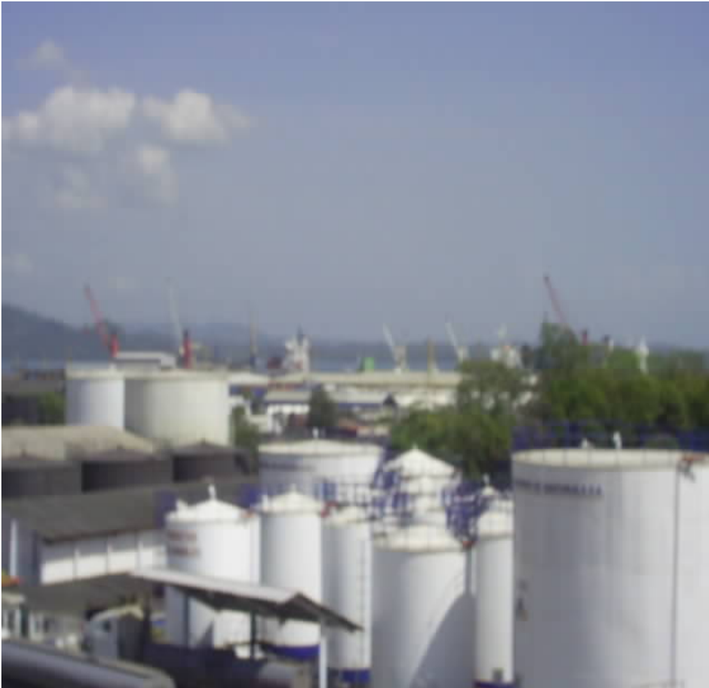
Figura 8. Área de tanques de almacenamiento.
