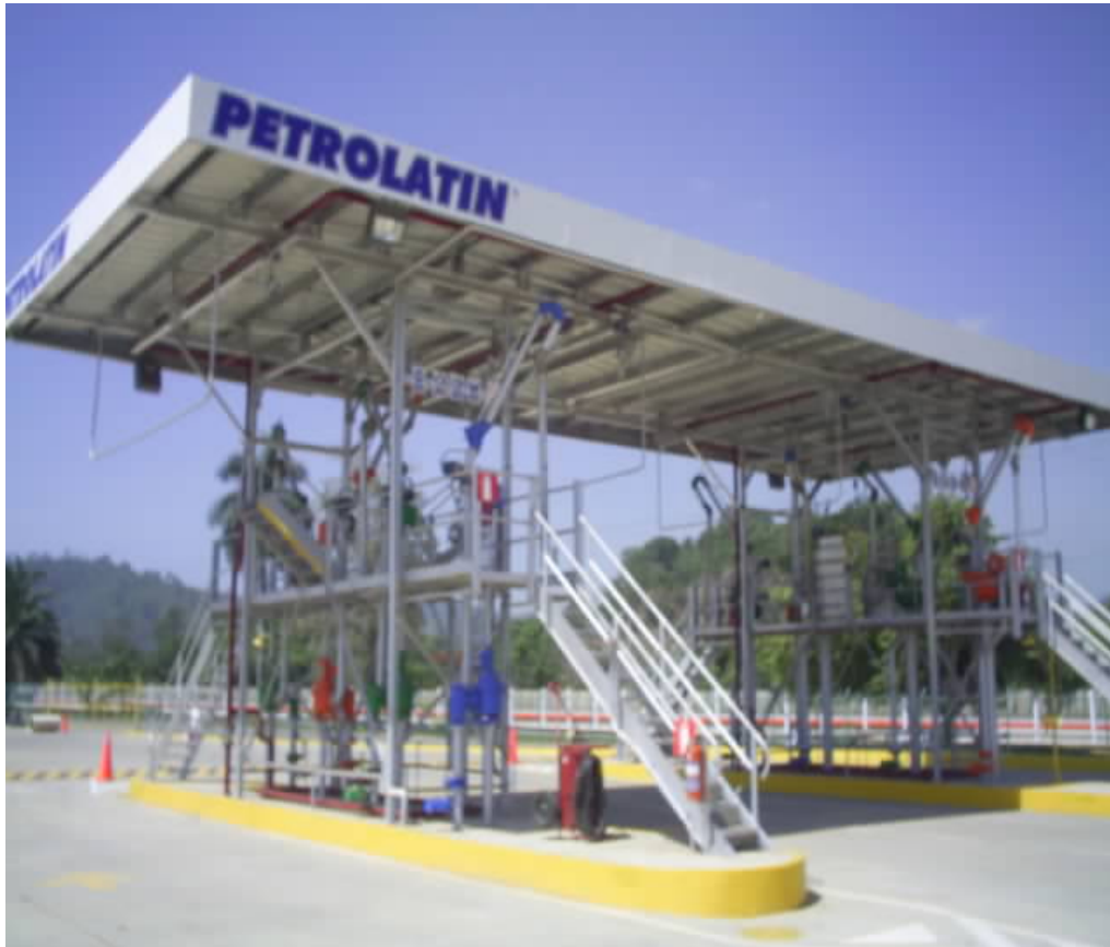
Figura 11. Área de carga para camiones abastecedores
