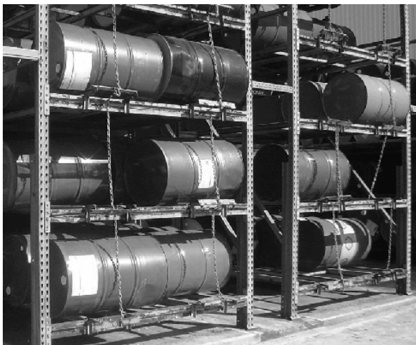
Figura 50. Almacenamiento de residuos de aceite.
