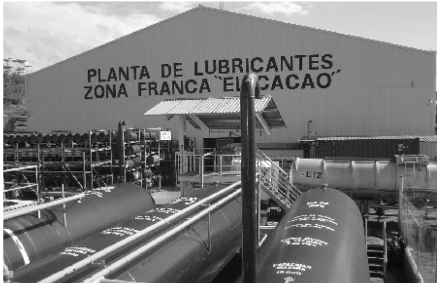
Figura 1. Planta de lubricantes de Shell Guatemala S.A.
